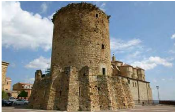
Torre Feudale S. Mauro Forte (MT)
